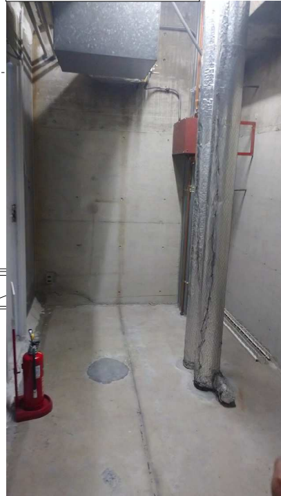
シャフト内写真
